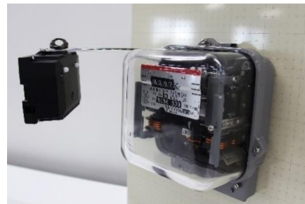
【遠隔監視ネットワークカメラの設置例】
